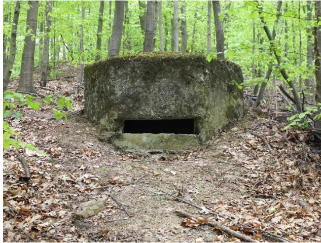
20. fotó. Hatszögletű DOT nagy lönyílással. A szerző felvétele az Utcási völgyzárban
