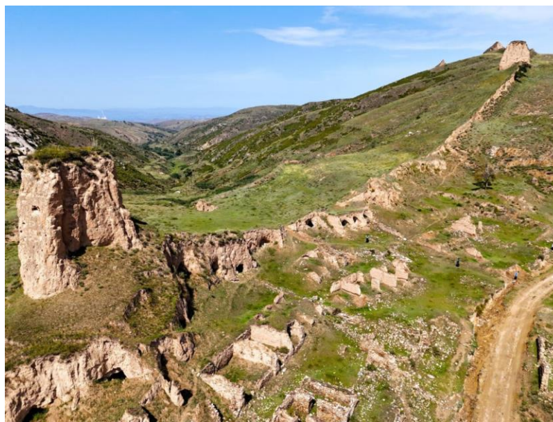
3. fotó. Döngölt agyagból készült fal mai maradványai 34
