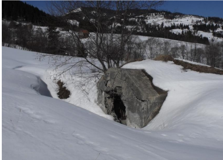
22. fotó. Félraj óvóhely. Belül látszik a hullámlemez helye. Körösmezői völgyzár. A szerző felvétele
